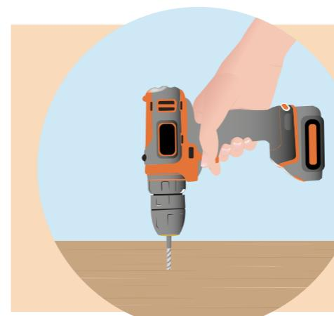
**NL:** Let op: indien het om een harde ondergrond gaat, zal je een gat moeten boren met een omvang en diepte die overeenkomt met de te plaatsen bus.
